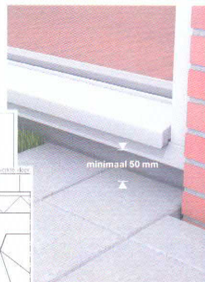
Afstand onderkant kozijn - bestrating
